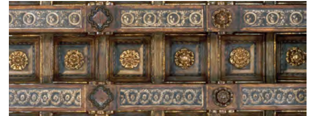
Detall del sostre enteixinat de fusta del Saló de Contractacions.
