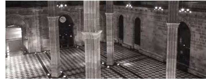
El Saló de Contractacions de la Casa Llotja de Mar és un únic espai de grans dimensions dividit en tres àmplies naus, cobertes amb un forjat de bigues de fusta policromada i definides per dues sèries de tres arcades semicirculars. Quatre esveltes columnes amb motllures sostenen els sis arcs del Saló.
